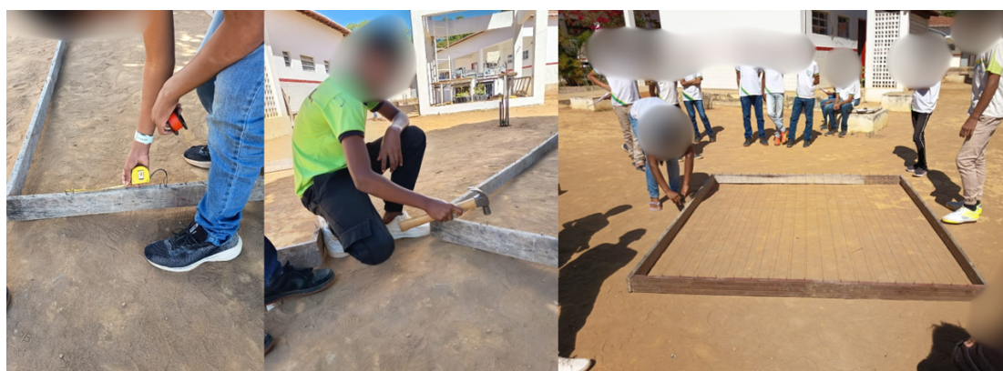
Figura 13 – Construção do espaço da horta
